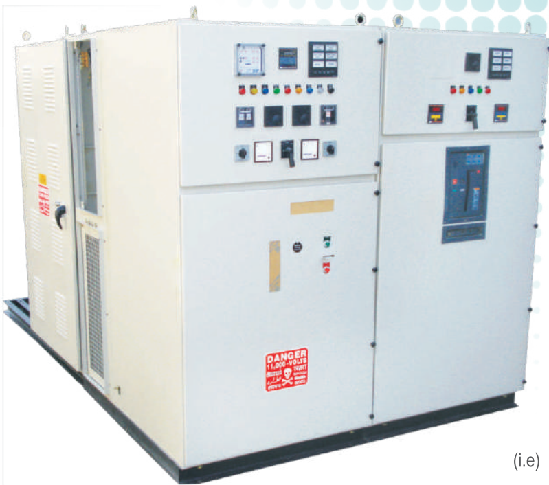
11KV, 2000 kVA USS PANEL - INDOOR
